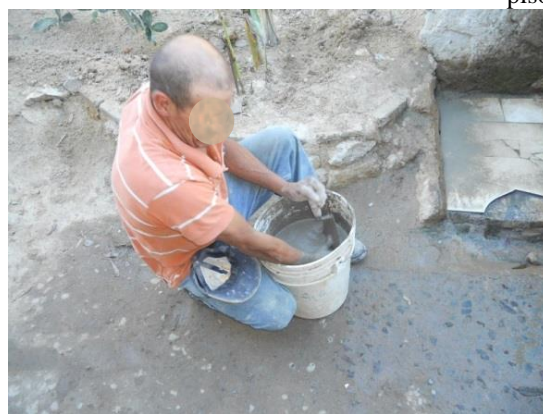
Imagen 8. Interno trabajando en instalación de piso
