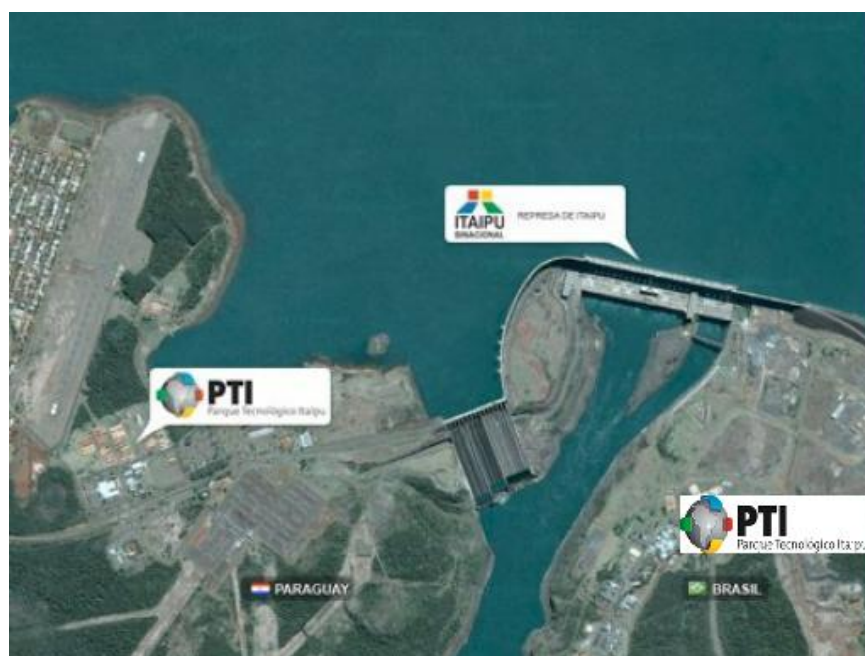
Mapa 1.3 Vista aérea de la Central Hidroeléctrica Itaipú Binacional, el PTI-BR y el PTI-PY
