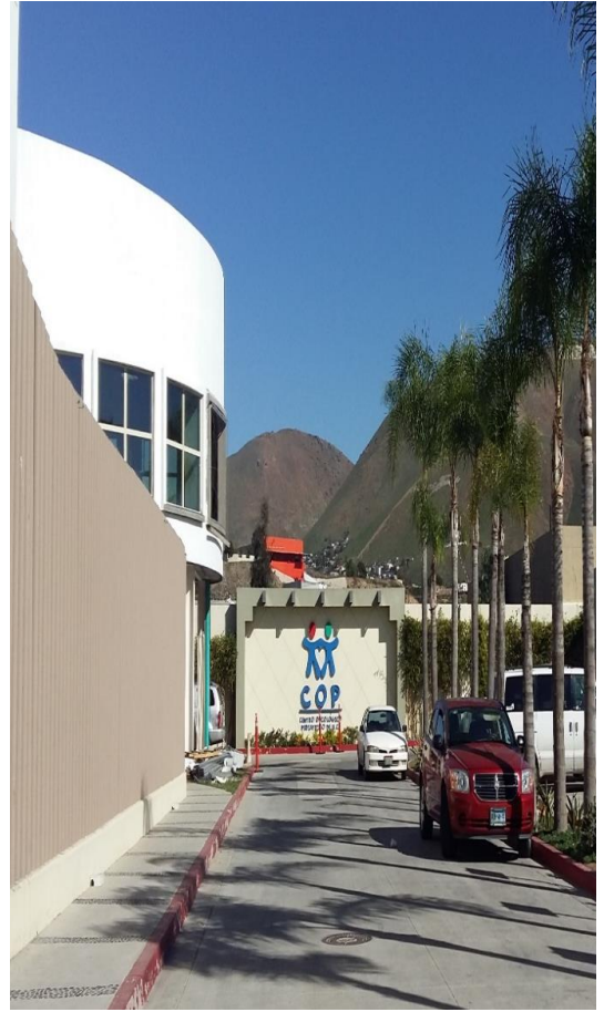
Fotografía 2. Fundación Castro Limón Instalaciones
