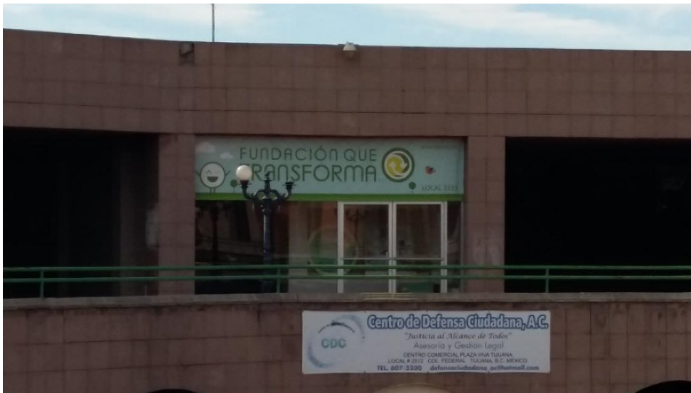
Fotografía 3. Fundación que Transforma instalaciones
