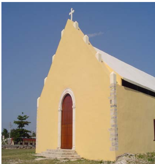
Foto 6. Exterior de la iglesia de Ucí después De ser reconstruida
