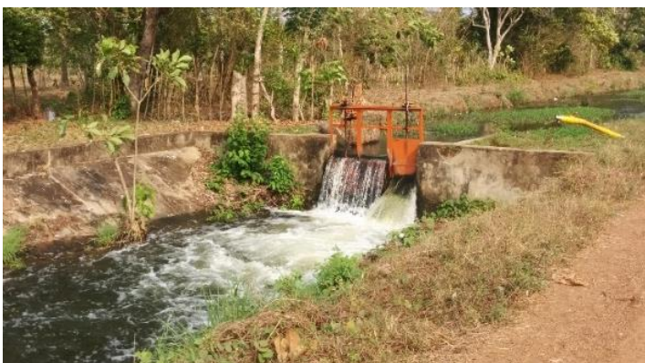
Fotografía 17. Compuerta de paso de canal secundario. María la Baja. Rendón, 2016.
