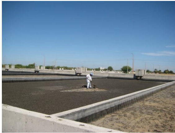
Fotografía 22. Recolección de lodos, manualmente
