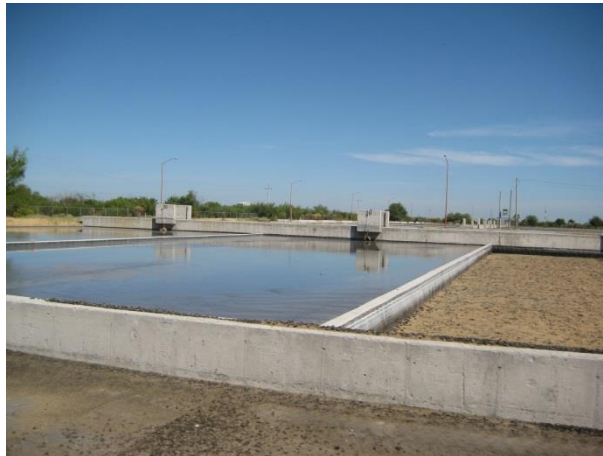
Fotografía 18. Lechos de secado
