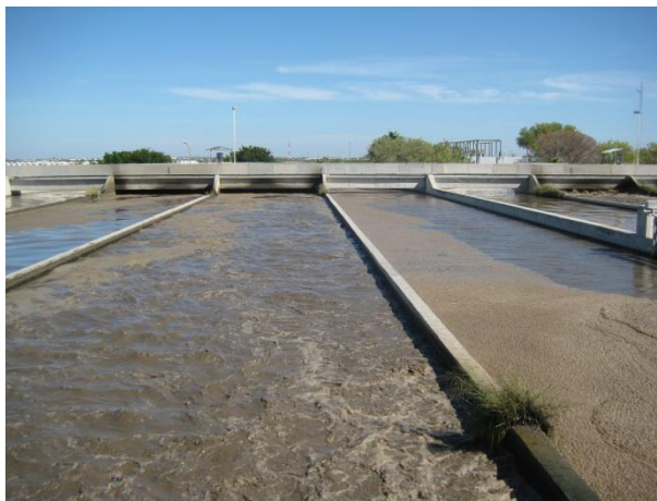
Fotografía 5. Zanjas de oxidación con y sin aireación
