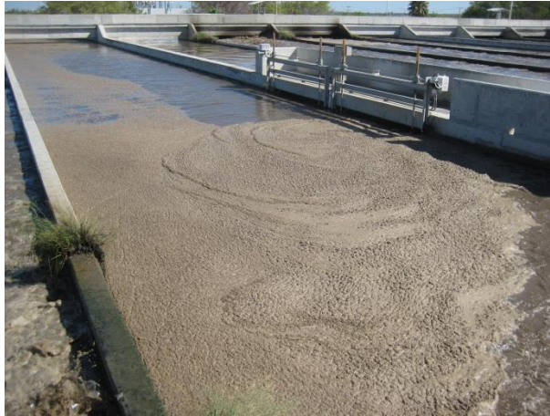
Fotografía 6. Zanjas de oxidación sin aireación
