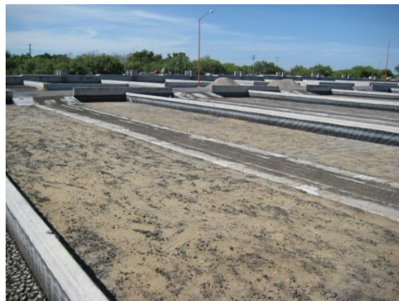
Fotografía 23. Lechos de secado sin lodo
