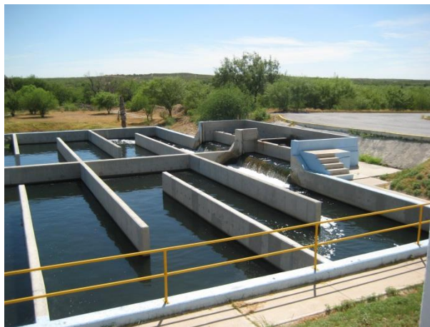
Fotografía 13. Tanque de contacto de cloro
