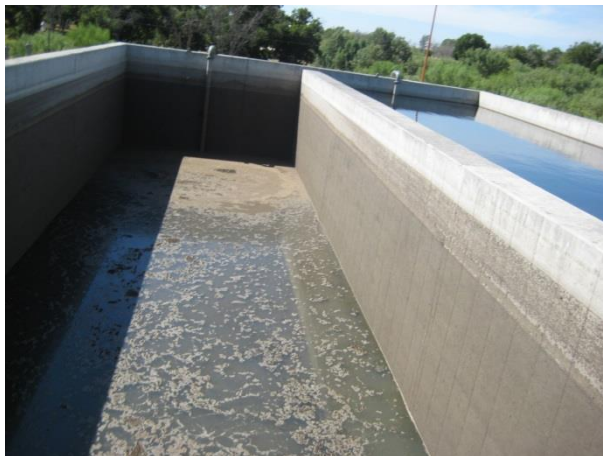
Fotografía 17. Sedimentación de los lodos digeridos
