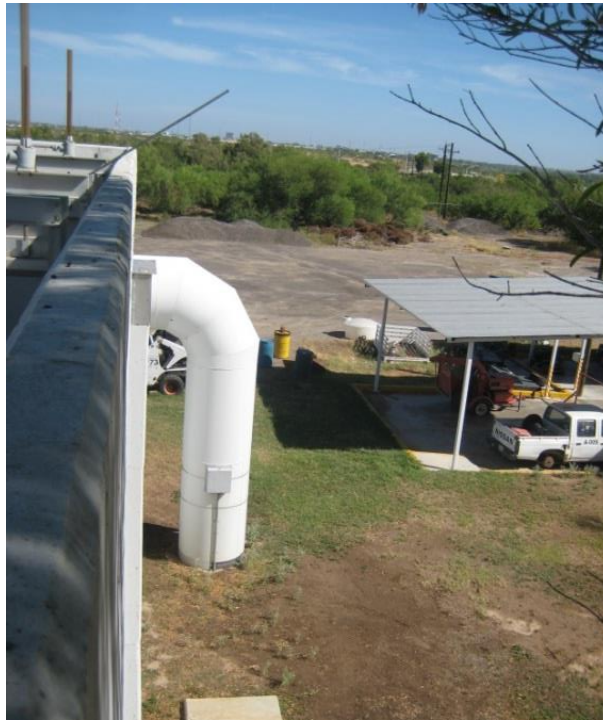
Fotografía 1. Cárcamo de llegada
