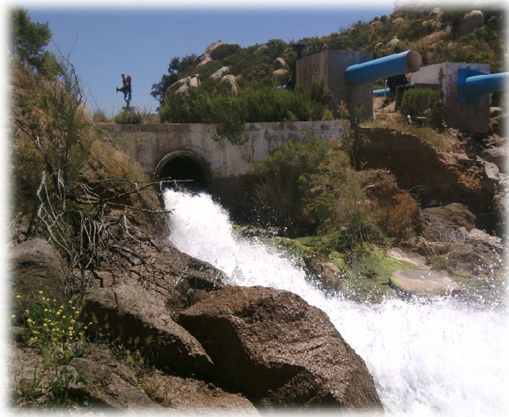
Ilustración 2 "Acueducto Rio Colorado-Tijuana"
